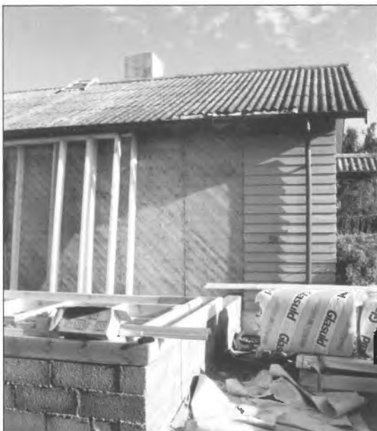
Ydervæg inden klinkbrædder kommer på.
